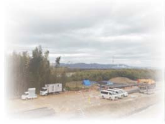
河川工事現場
